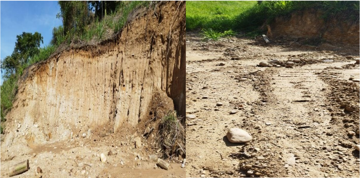
Terraza inferior, huella del arranque y las Huellas evidencia del tránsito de maquinaria pesada
